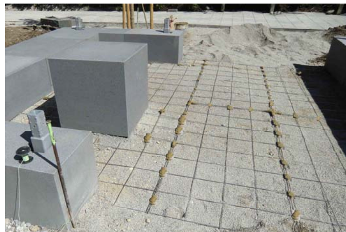
Bild 6: Potentialsteuerung in einer Schutzhütte
